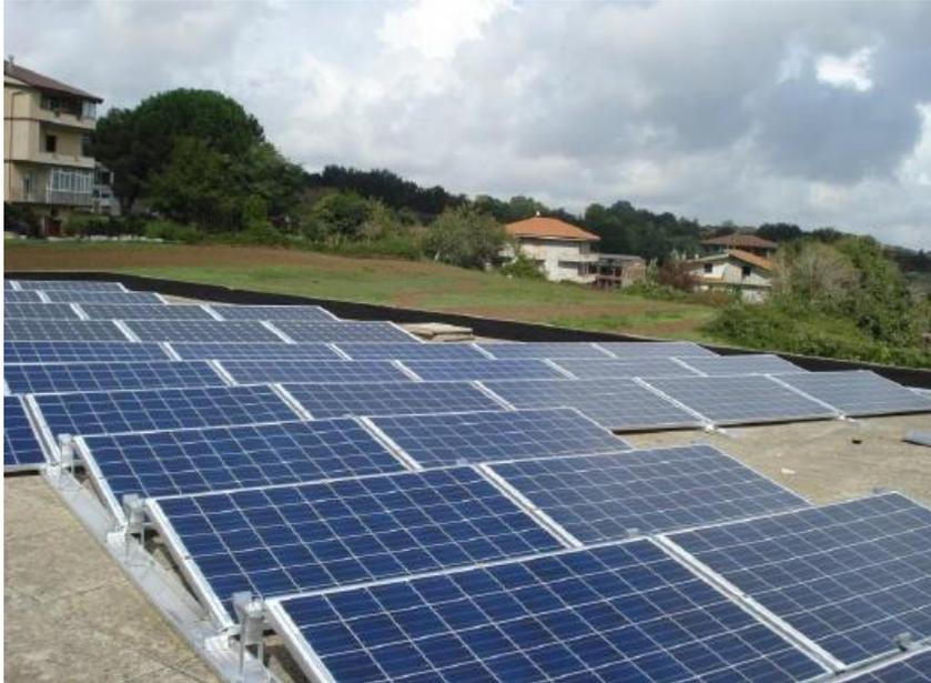
L'impianto fotovoltaico, da **11 kW**, composto da 44 moduli in silicio policristallino Solarworld Sunmodule Plus SW250 ed inverter ABB, è stato finanziato interamente dal Ministero dello Sviluppo Economico tramite il **Programma Operativo Interregionale sulle energie rinnovabili e l'efficienza energetica**.
