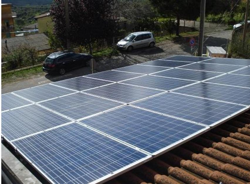
L'impianto fotovoltaico, da **29 kW**, è composto da 116 moduli in silicio policristallino Solarworld Sunmodule Plus SW250 ed inverter ABB.
