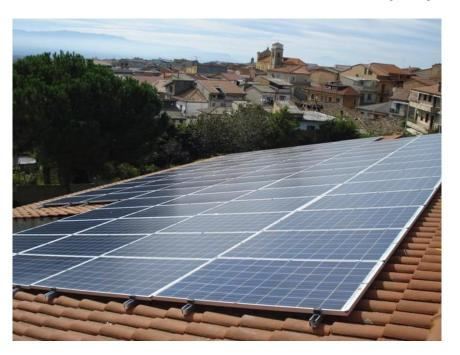
L'impianto fotovoltaico, da **24,75 kW**, è composto da 99 moduli in silicio policristallino Solarworld Sunmodule Plus SW250 ed inverter ABB.
