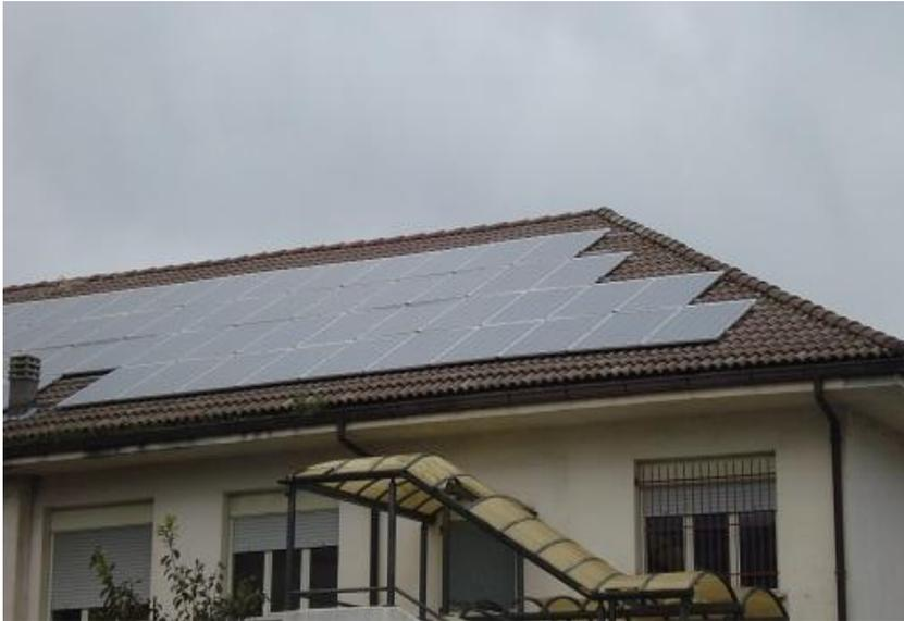
L'impianto fotovoltaico, da **22,5 kW**, è composto da 90 moduli in silicio policristallino Solarworld Sunmodule Plus SW250 ed inverter ABB.
