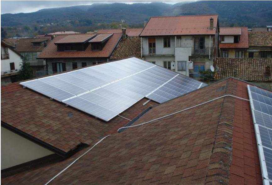
L'impianto fotovoltaico, da **19,25 kW**, è composto da 77 moduli in silicio policristallino Solarworld Sunmodule Plus SW250 ed inverter ABB.
