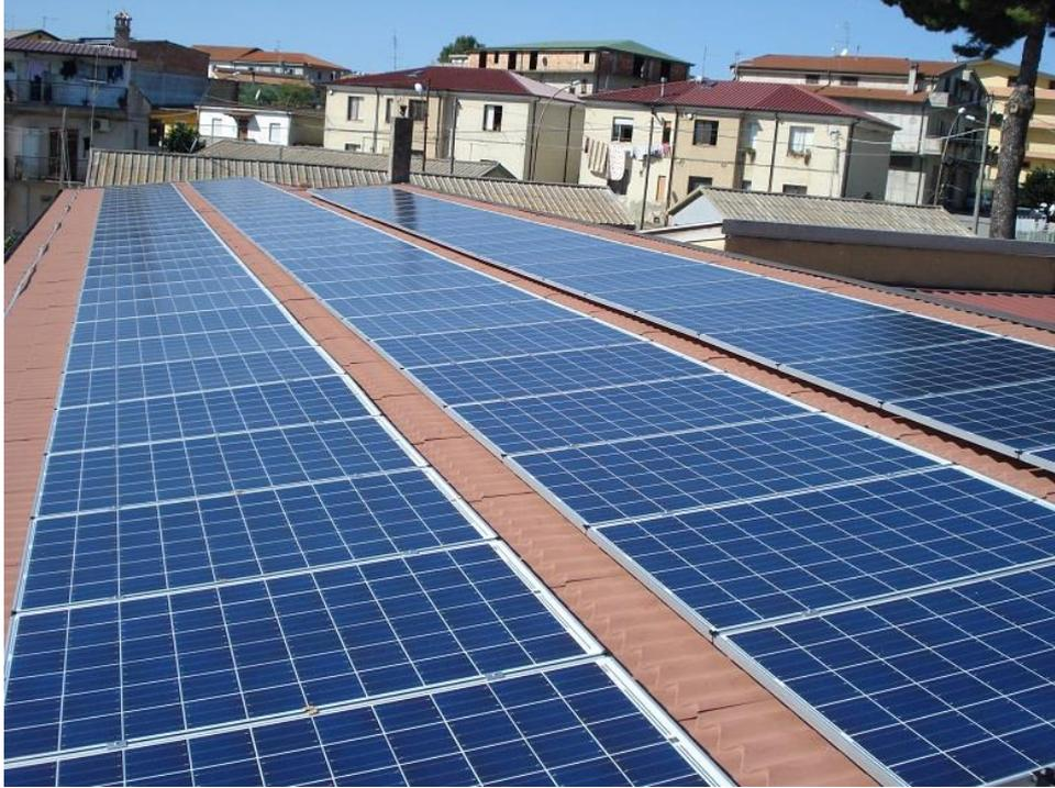
L'impianto, composto da moduli in silicio policristallino Solarworld Sunmodule Plus SW250 ed inverter ABB, è stato finanziato interamente dal Ministero dello Sviluppo Economico tramite il Programma Operativo Interregionale sulle energie rinnovabili e l'efficienza energetica.
