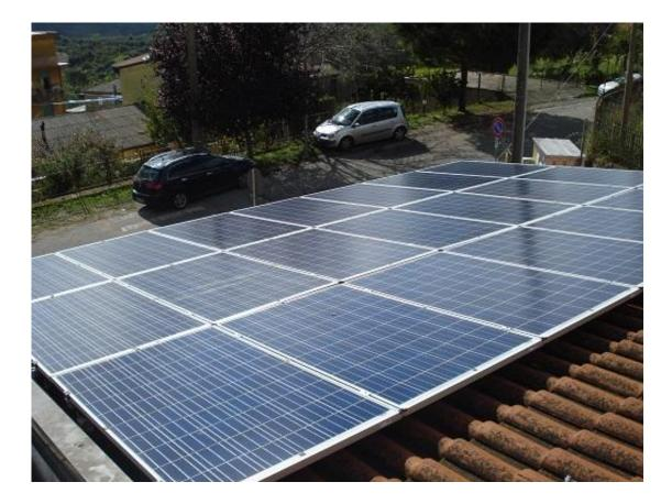
L'impianto fotovoltaico, da 29 kW, è composto da moduli in silicio policristallino Solarworld Sunmodule Plus SW250 ed inverter ABB, è stato finanziato interamente dal Ministero dello Sviluppo Economico tramite il Programma Operativo Interregionale sulle energie rinnovabili e l'efficienza energetica.
